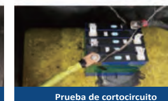
Prueba de cortocircuito
